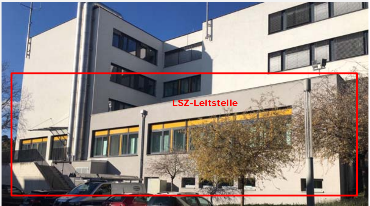
Abbildung 1: Außenaufnahme der LSZ - Teilansicht (Leitstelle)
